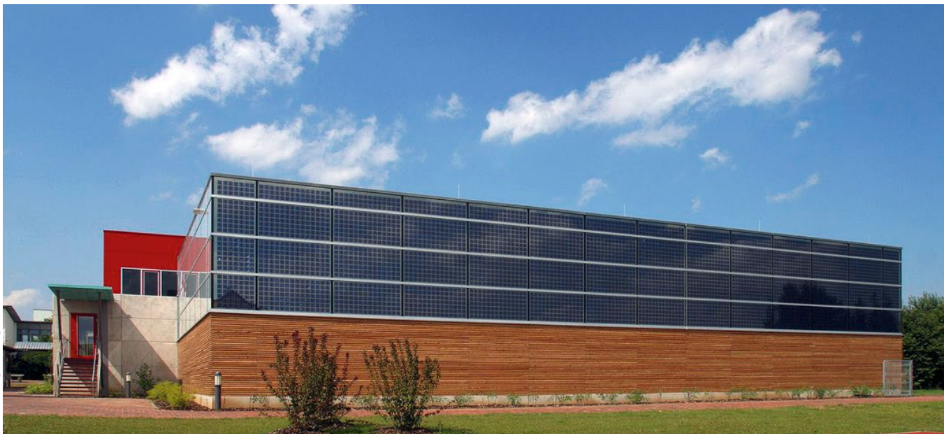
Sporthalle mit Photovoltaik-Fassade in Regensburg
