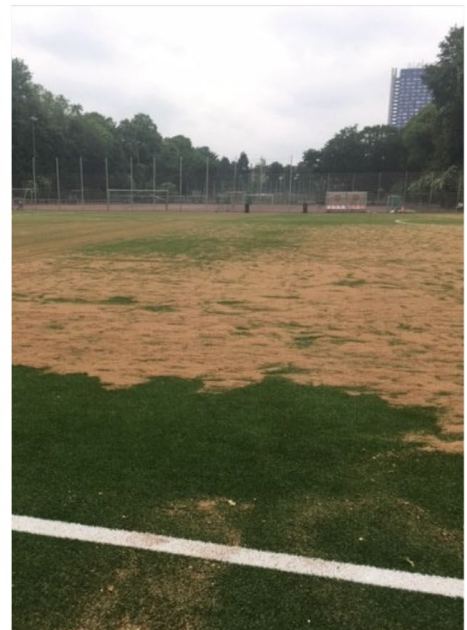
Verklumptes Kunststoffgranulat sowie hohe Oberflächentemperaturen und aufgeschwommenes Korkgranulat nach Wetterextremen auf Sportanlagen im Kölner Stadtgebiet.
